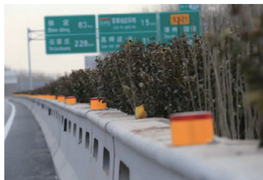
安装在中央隔离带上的柱帽式轮廓标
